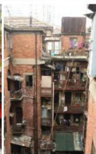
“大巴公房子” 内天井 (2015年)
