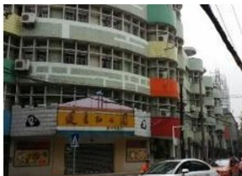
1、建筑东北面为健康幼儿园。
