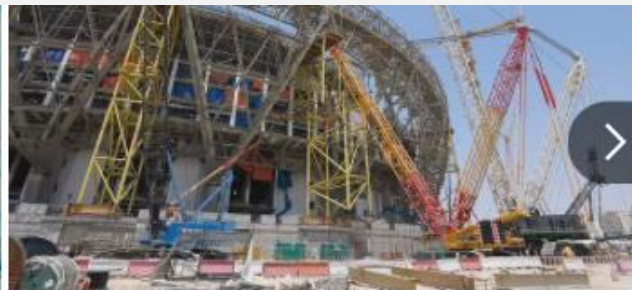
卢赛尔体育场项目建设现场俯拍
