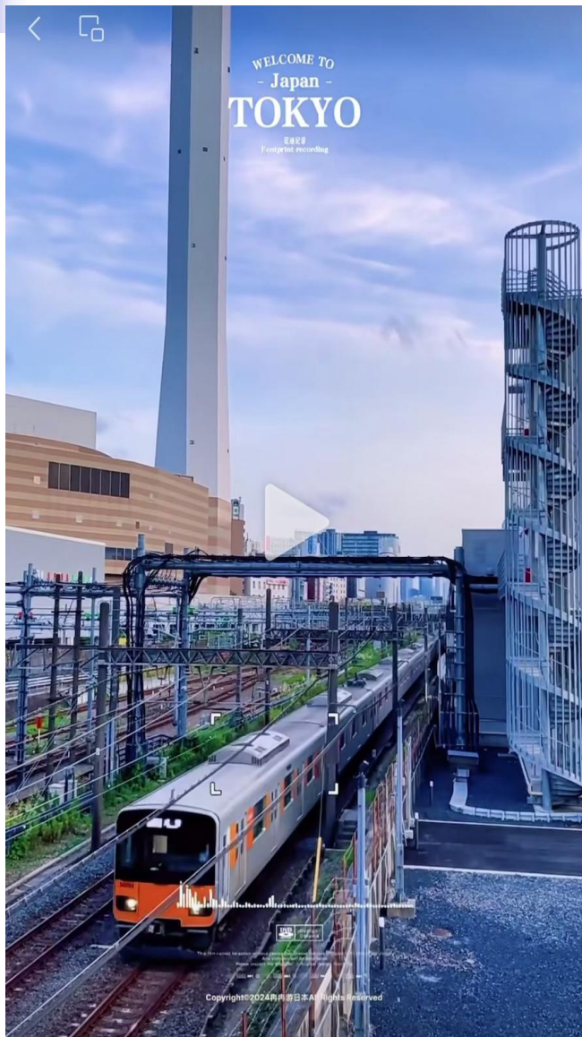
池袋站旁边的豊島区垃圾焚烧厂
