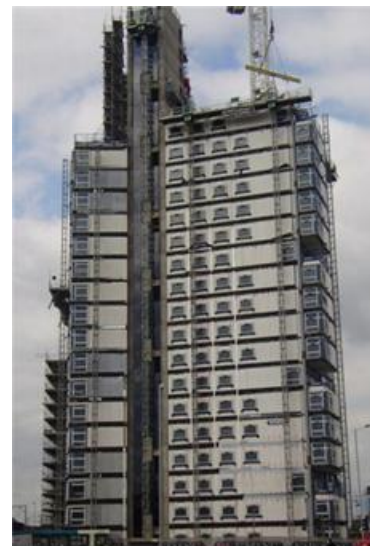
建造中的模块化建筑
