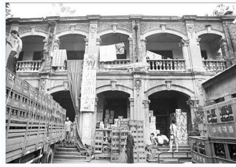
房屋成批发仓库杂草丛生，墙面被污水腐蚀成危墙
