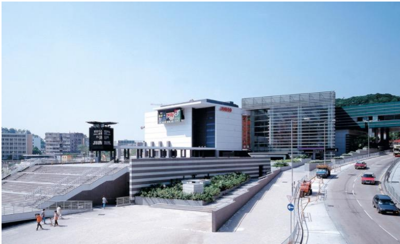
乐富地铁站地铁上盖物业，乐富中心
