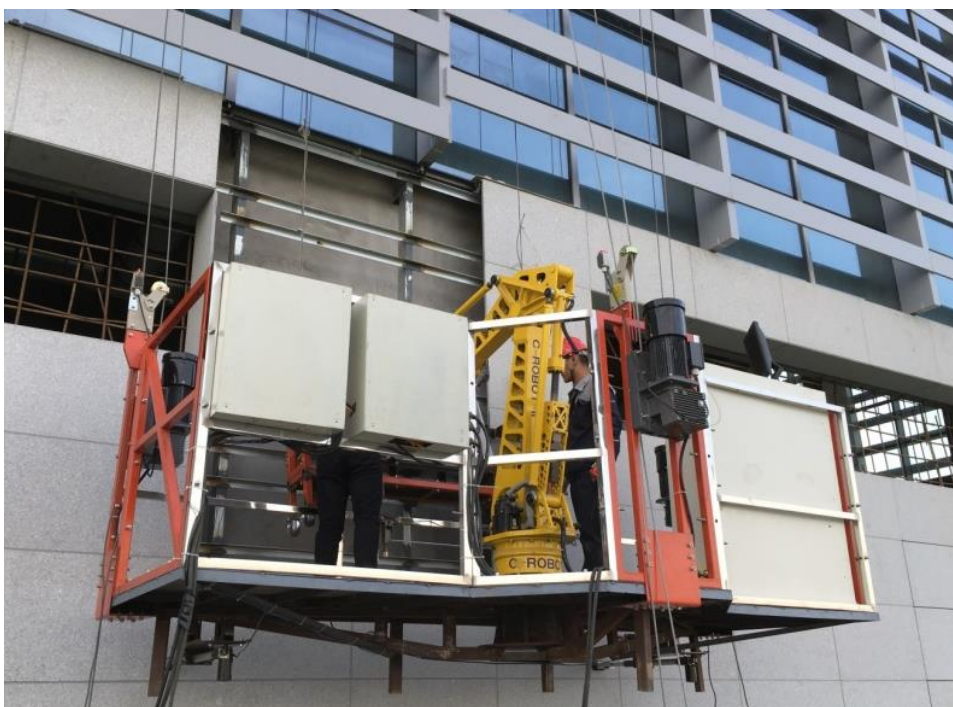
板材安装机器人实际操作作业
