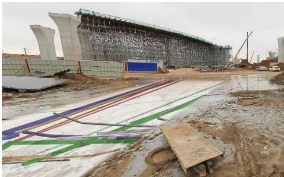
地下管线 AR 施工指导
