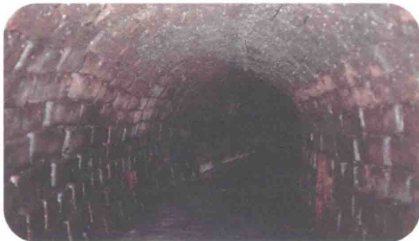
一八六五年，纽约市在巴豆渡槽部的监管下开始下水道建设，使用的材料主要是砖块。
